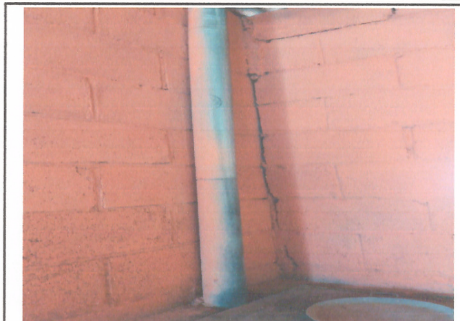
Foto 2: MEJORAMIENTO DE COLUMNAS INTERMEDIAS DEL AREA DE COCINA
