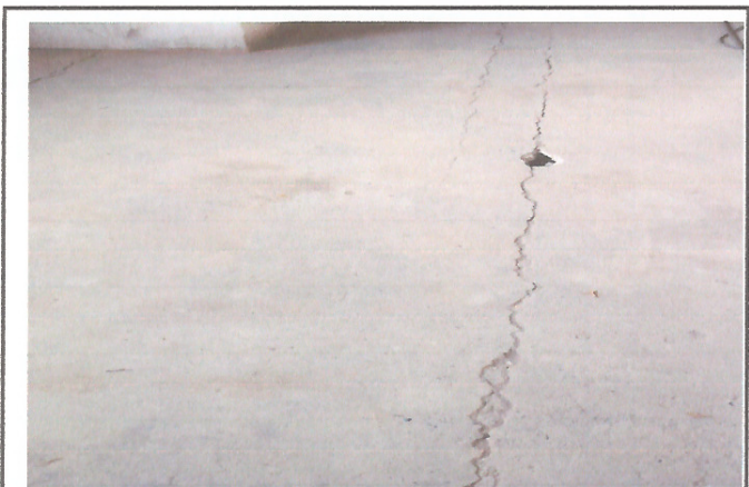
Foto 3: CAMBIO DE PISO DEL AREA DE COCINA
