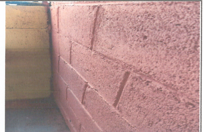
Foto 8: MEJORAMIENTO DE PAREDES
