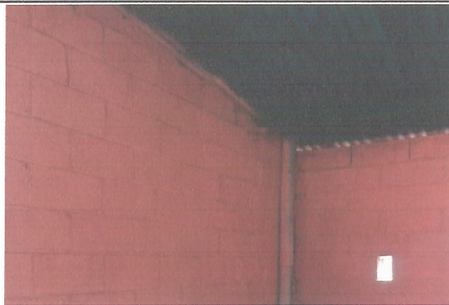
Foto 7: MEJORAMIENTO DEL TECHO DEL AREA DE COCINA
