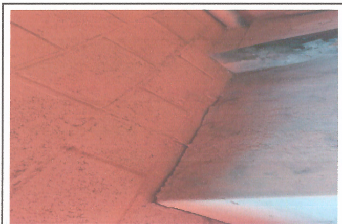
Foto 4: REPARACIÓN DEL POLLETON
